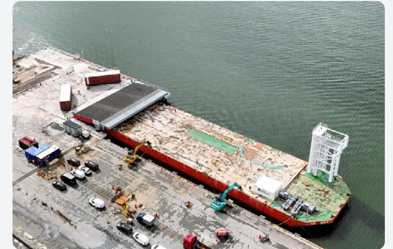
MacGregor Linkspans konstruerades med återvunnet stål i Göteborgs hamn.
